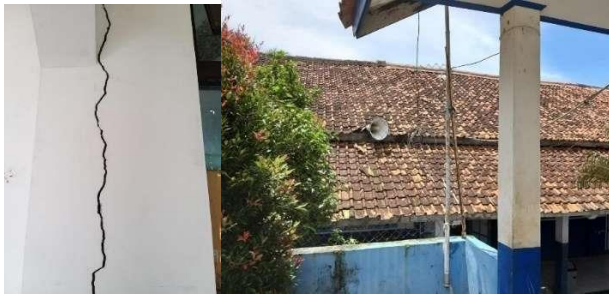
Gambar 14. Kondisi Gedung Eksisting Gedung SMPN 1 Ciranjang
