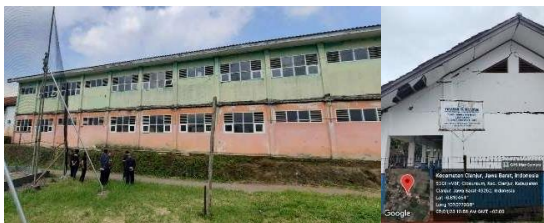
Gambar 9. Kondisi Gedung Eksisting Gedung SMP Budi Luhur
