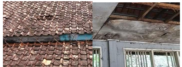
Gambar 13. Kondisi Gedung Eksisting Gedung SMP 2 Mande
