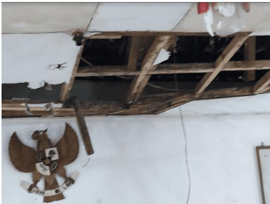
Gambar 8. Kondisi Gedung Eksisting Gedung SMP Pasundan 2 Cianjur
