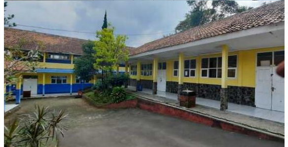
Gambar 10. Kondisi gedung eksisting gedung SMP N 2 Cipanas Kab. Cianjur
