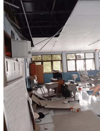
Gambar 5. Kondisi Gedung Eksisting Gedung SD BPK Penabur Cianjur
