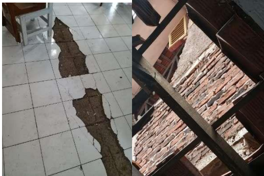
Gambar 1. Kondisi Gedung Eksisting Gedung SD Negeri Ibu Dewi 1 Cianjur
