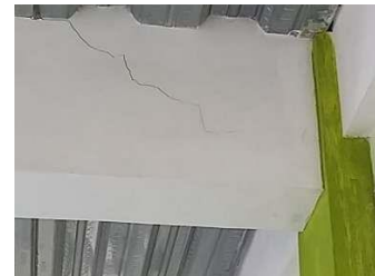
Gambar 11. Kondisi Gedung Eksisting Gedung SMP Garnesia
