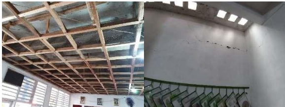
Gambar 2. Kondisi Gedung Eksisting Gedung SD Negeri Ibu Dewi 4 Cianjur
