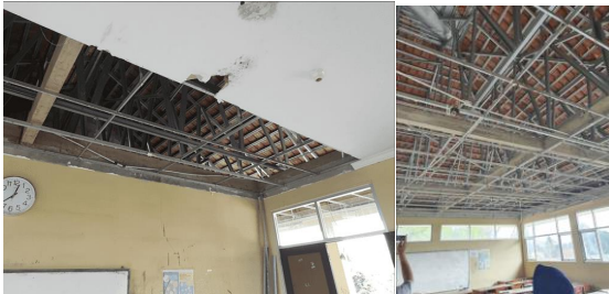
Gambar 7. Kondisi Gedung Eksisting Gedung SMP An Nur Hadist
